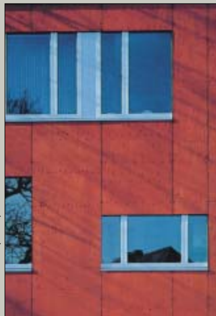
El revestimiento de fachada se realiza con alistonado de madera de picea, teñida con pigmentos anaranjados, que mejoran su protección contra los rayos U.V. A pesar de la coloración se aprecia la veta y la textura de la madera.
