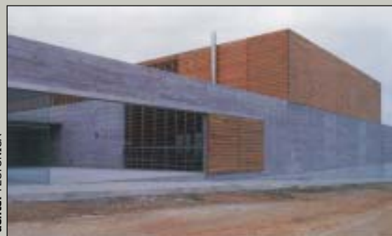
Piscina en Laracha (A Coruña). Revestimiento de madera tratado con sales de cobre.
