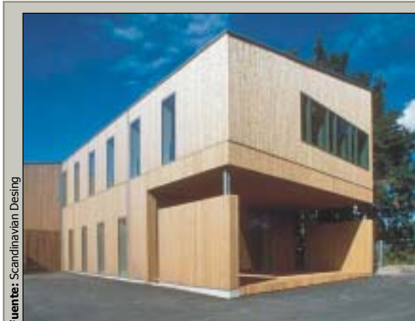
Revestimiento de fachada con madera termotratada
