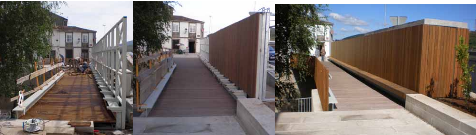
Pasarela peatonal metálica revestida con madera tropical de ipé, Santiago de Compostela (A Coruña)
