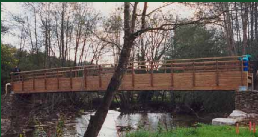
Pasarela en el río Chamoso 20x2 m (Lugo)
