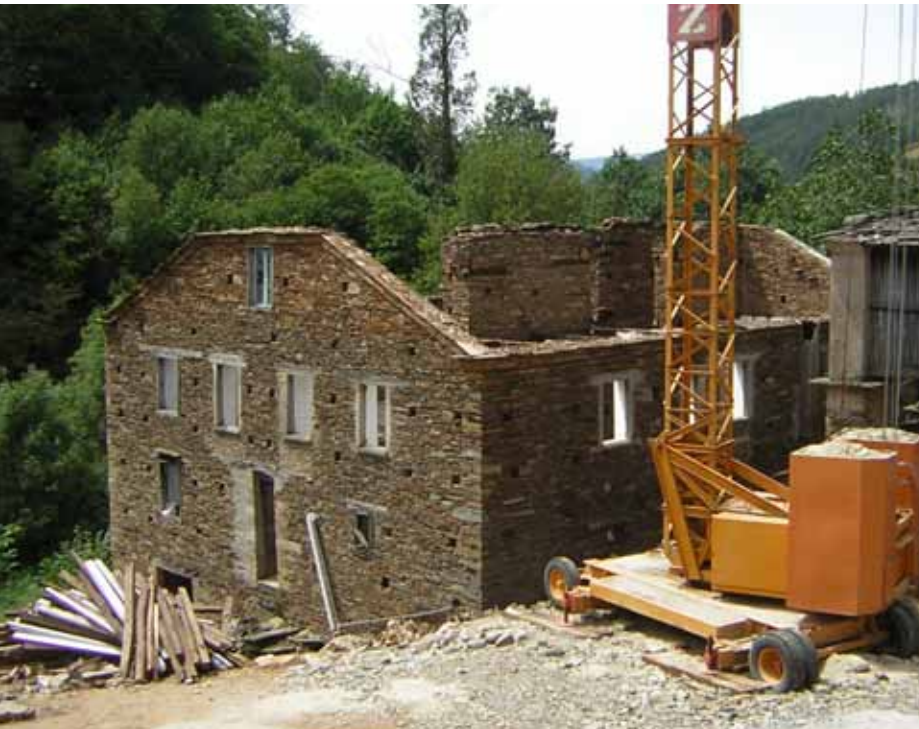
Rehabilitación de casa de turismo rural en Machuco, A Pontenova (Lugo): demolición previa, formación de forjados mixtos y cubierta.
