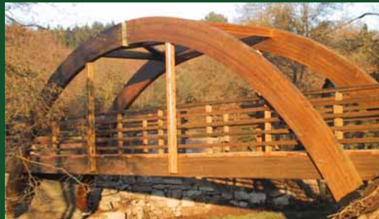
Pasarela en el río Chamoso 14x2 m (Lugo)
