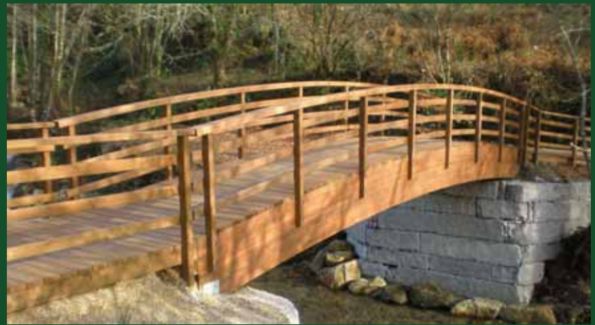
Pasarela peatonal en el río Lézrez 10x2 m (Pontevedra)
