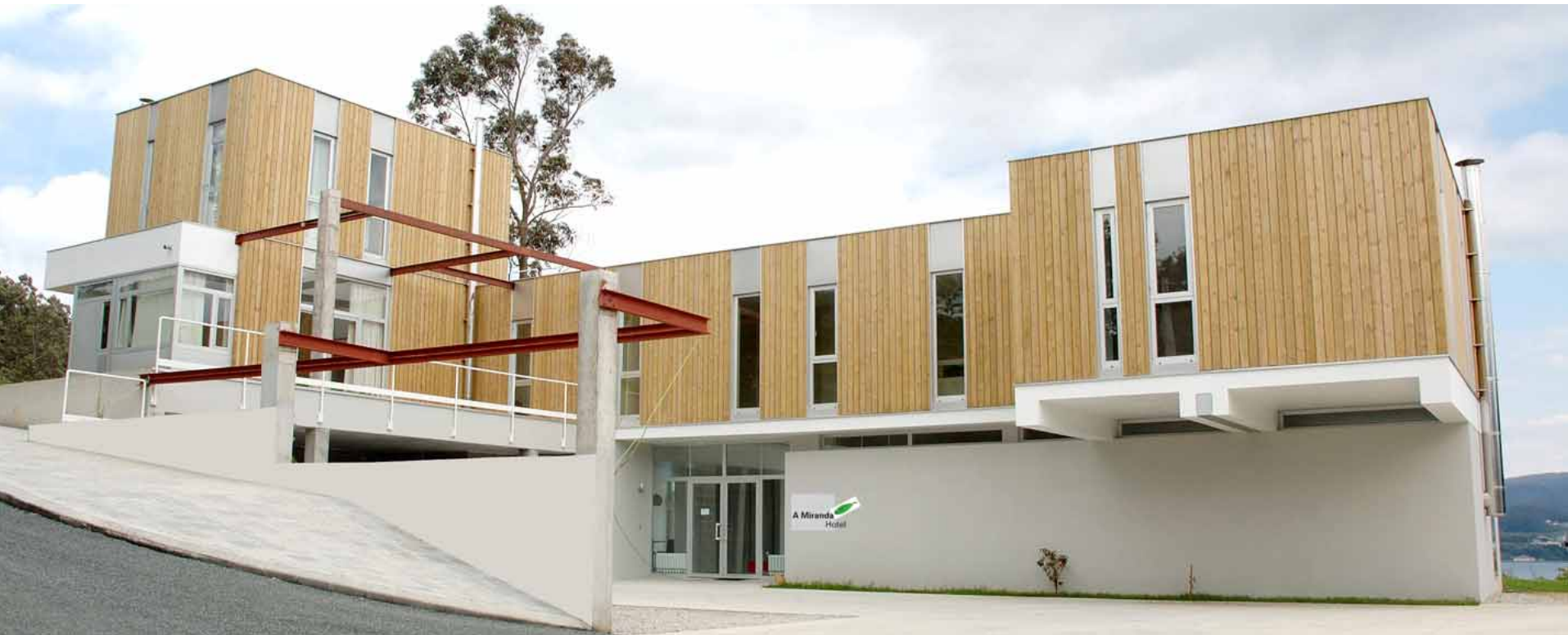
Fachada ventilada de pino norte tratado en autoclave, hotel de turismo rural A Miranda, Cariño (A Coruña)
