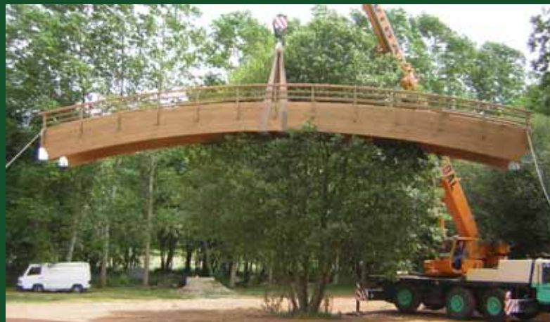
Pasarela en Láncara 18x2 m (Lugo)
